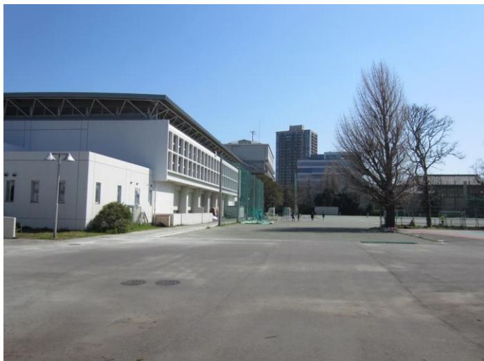
図1 中学の校舎の方向から敷地を見る
