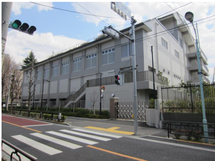
図 13 道路を挟み隣地の音羽中学を見る プロポーザル敷地は写真の右端
