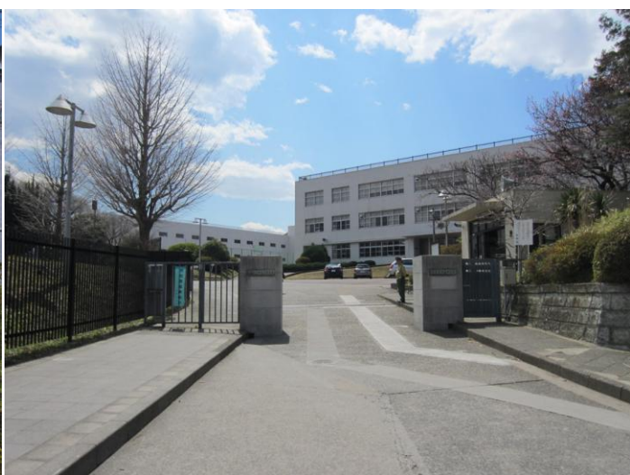
図10 附属の正門を外部から見る
