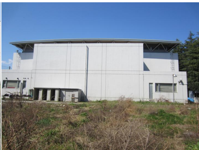
図6 敷地から体育館側面を見る
