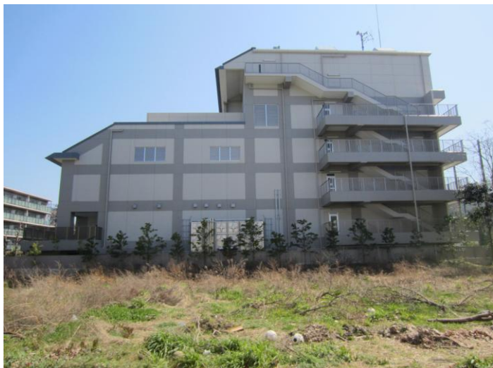
図7 敷地から隣地建物（現在は音羽中学校）を見る
